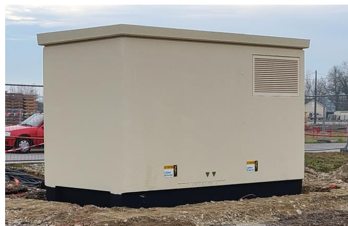
Vues des faces avant et arrière d'un poste transformateur et poste de livraison de 800 KVa
