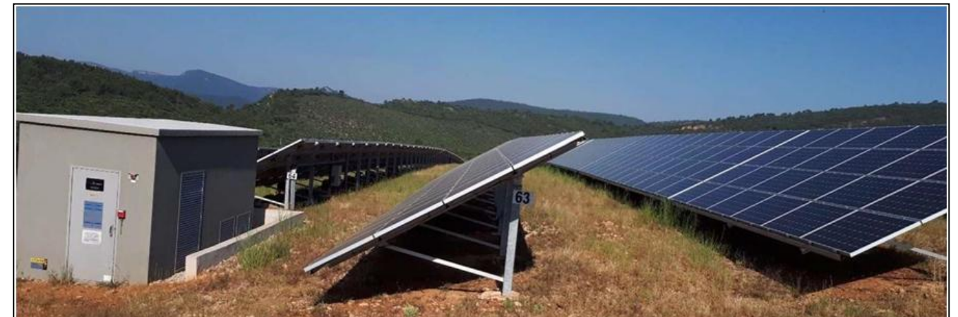
Figure 3 : Photographie d'une centrale photovoltaïque au sol – tables et ancrage au sol
