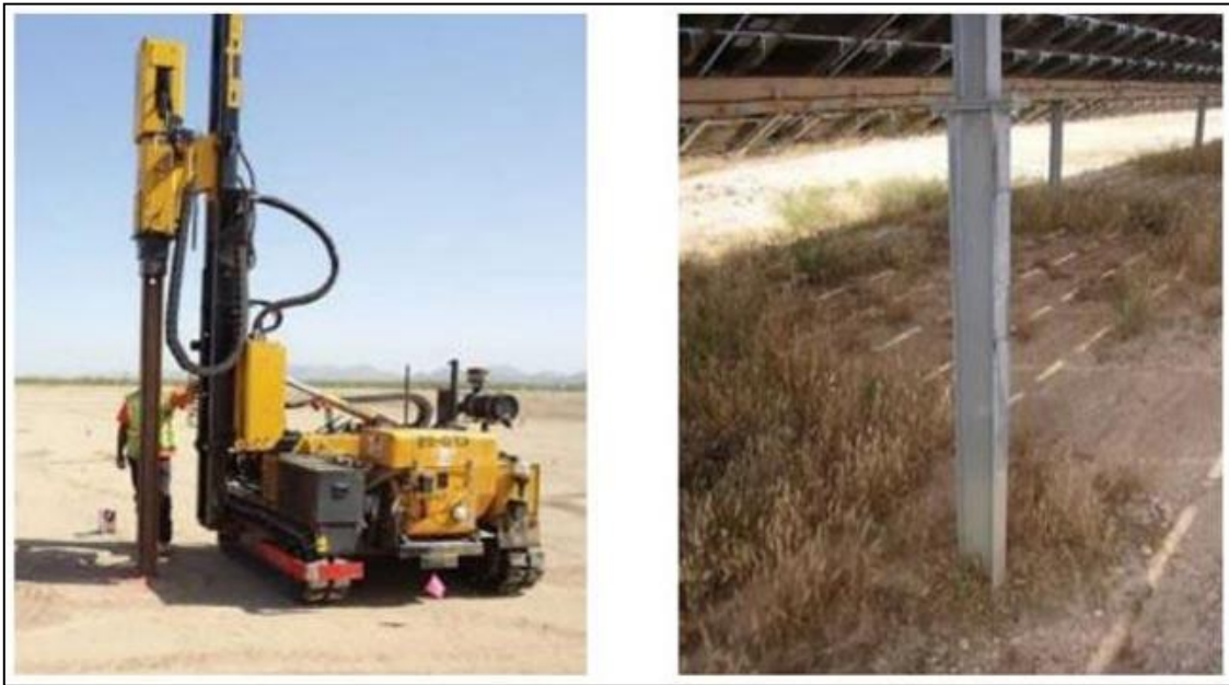
Figure 4 : Technique d'ancrage des pieux battus
