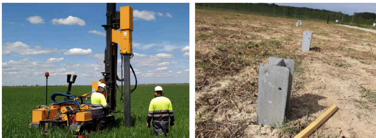
Figure 10 : Illustration de travaux de fondations avec pieux battus
