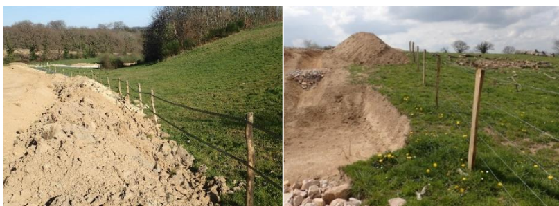
Figure 11. Exemple de balisage des emprises de chantier (Source Crexeco)
