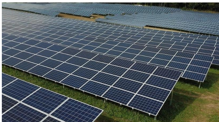
Figure 3 : exemple de table photovoltaïque sur pieux en 4H.
