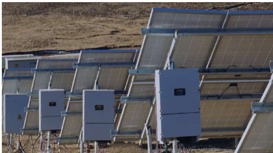
Figure 11 : Exemple d'onduleurs strings en bout de rangées
