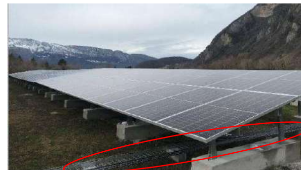
Figure 10 : Exemple de chemins de câbles hors sol
