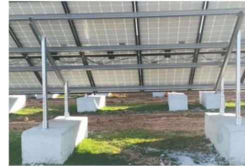
Figure 7 : Fondations de surface
