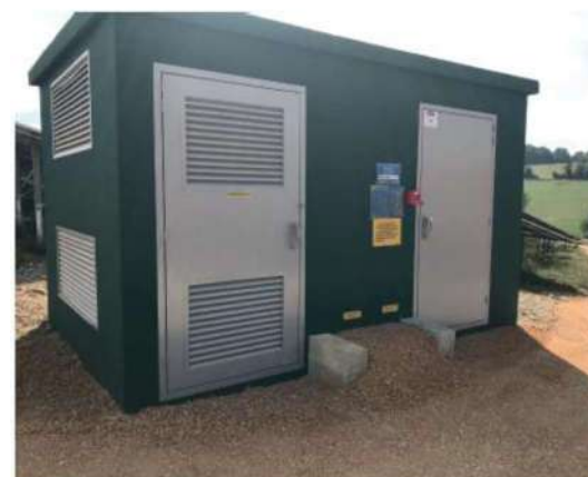
Figure 12 : Exemple de poste de transformation
