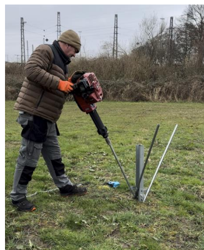
Principe des structures et fondation XGROUND d'Adiwatt et mise en œuvre au marteau perforateur
