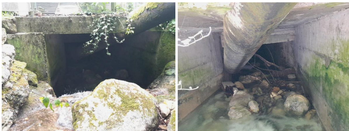
Figure 15 : Ouvrage sous l'immeuble de l'ancienne papeterie, et conduite plongeant en biais dans l'ouvrage
