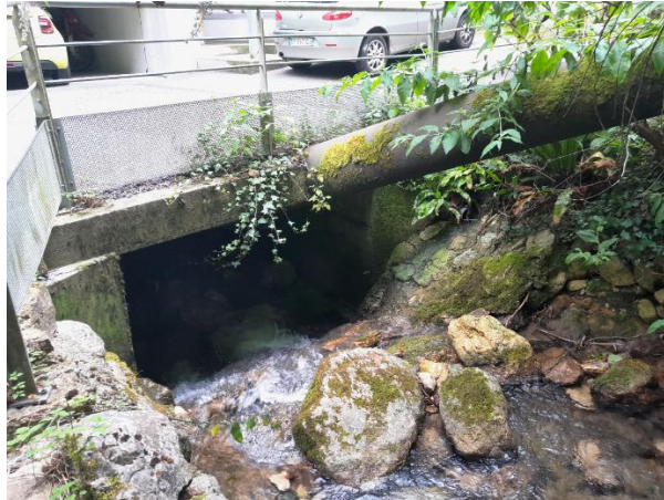
Figure 1 : Conduite arrivant sous l'ouvrage de franchissement de l'ancienne papeterie
