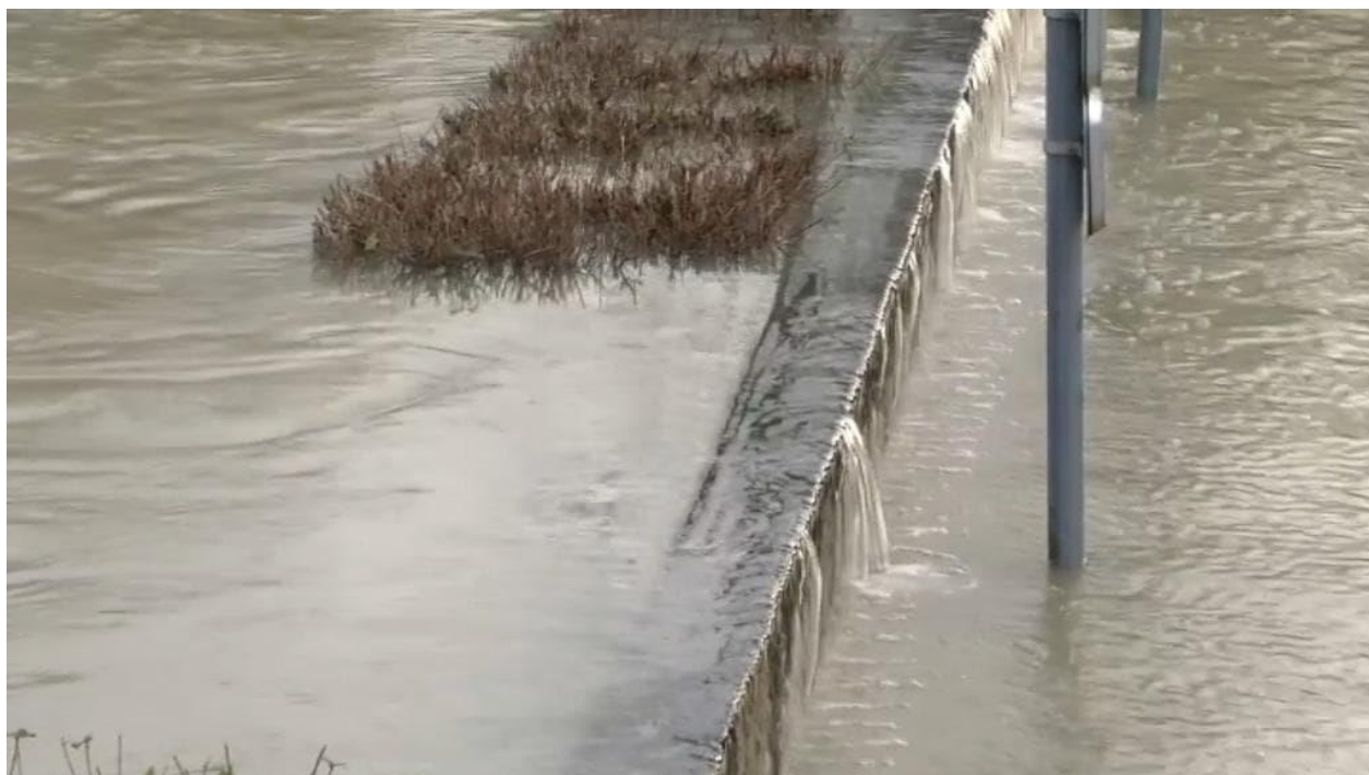
Figure 42 : Mur anti-crue situé sur la Marne, surverse sans rupture
