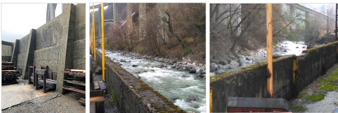
Figure 13 : Illustration du mur Est de l'Usine (contreforts, réhausse). Source : Lombardi
