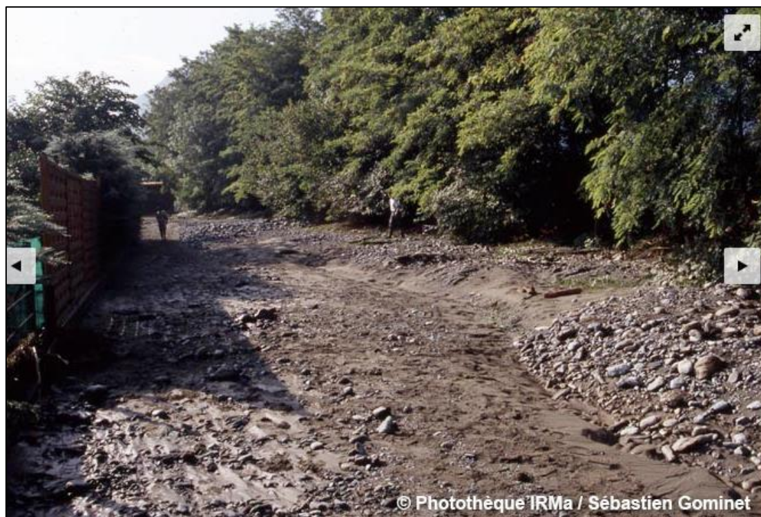
Figure 41 : Apperçu des dépôts solides en sortie du lit du Domeynon avec la crue torrentielle survenue sur ce dernier. La digue de protection en remblai n'a pas résisté à la surverse
