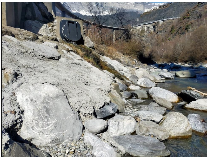
Figure 48 : Buse d'évacuation des eaux présentes dans le fossé derrière le mur nord de l'usine de Chedde et son clapet anti-retour
