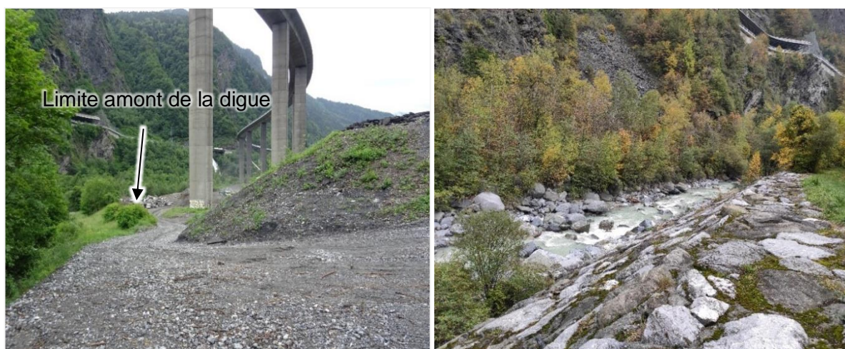
Figure 11 : Illustration des caractéristiques de la digue amont (accès, enrochement). Source : Lombardi
