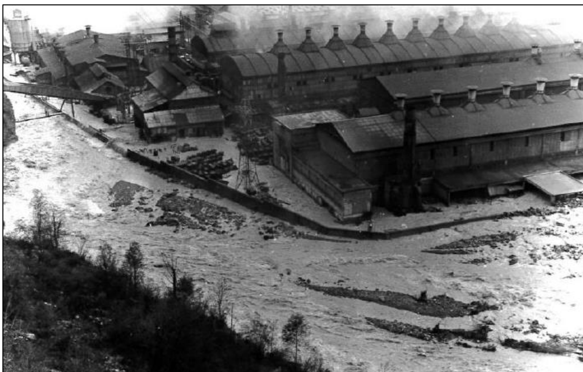
Figure 47 : Surverse sur le mur Nord de l'usine de Chedde lors de la crue de 1968
