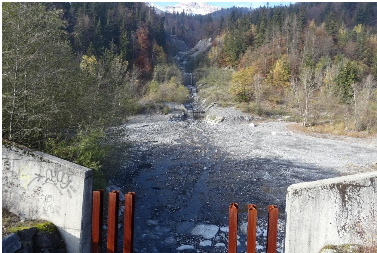
Figure 50 : Plage de dépôt (RD13) du Nant-Bordon vue depuis l'aval, source : Acthys Diffusion
