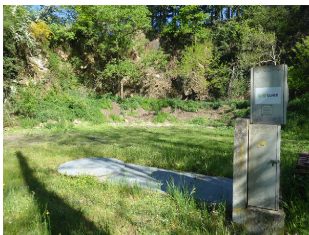
Poste de relevage sur le collecteur eaux usées
