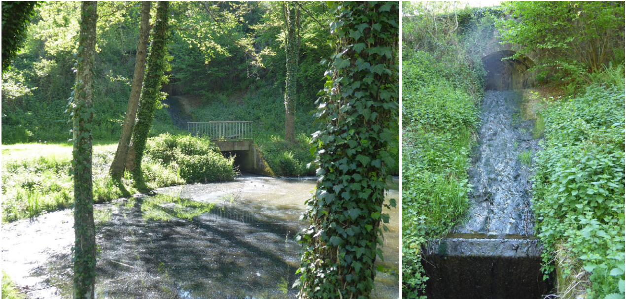
Débouché du ruisseau amont en queue de retenue : Ouvrage hydraulique infranchissable par le poisson
