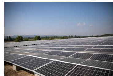
Exemple de centrales sur plots béton
