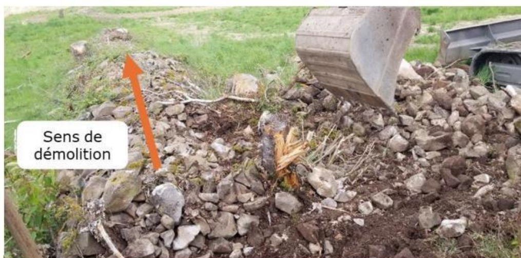
Figure 26 - Exemple de démolition d'un muret section par section (source : Eco-Stratégie)
