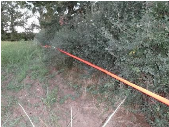
Exemple de balisage des emprises de chantier (Source Crexeco)
