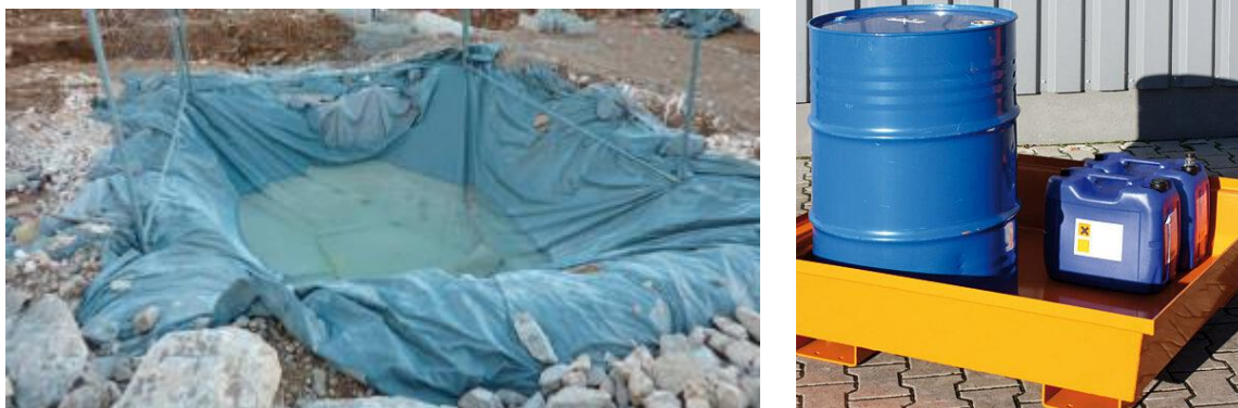
Figure 13. Stockage de matériaux polluants sur lieu étanche (à gauche) et fosse étanche de récupération des résidus de nettoyage, laitance béton, etc (à droite)
