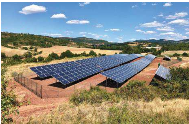
Exemple de structures fixes. Source : parc solaire de 249 kWc à Lagarde à Camares dans l'Aveyron (12) d'Enercoop Midi-Pyrénées sur une ancienne décharge
