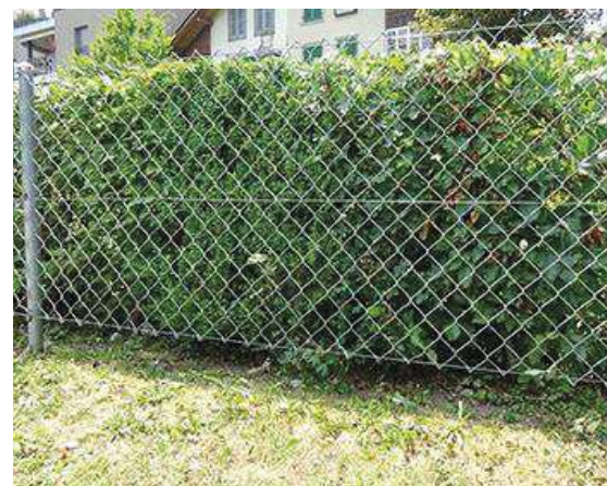
Exemple de grillage torsadé surélevé de 20 cm pour permettre le passage de la petite faune
