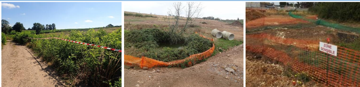
Figure 9. Exemples de mise en défens à éviter (Source Crexeco)
