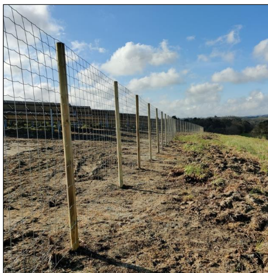
Exemple de clôture d'une centrale photovoltaïque
