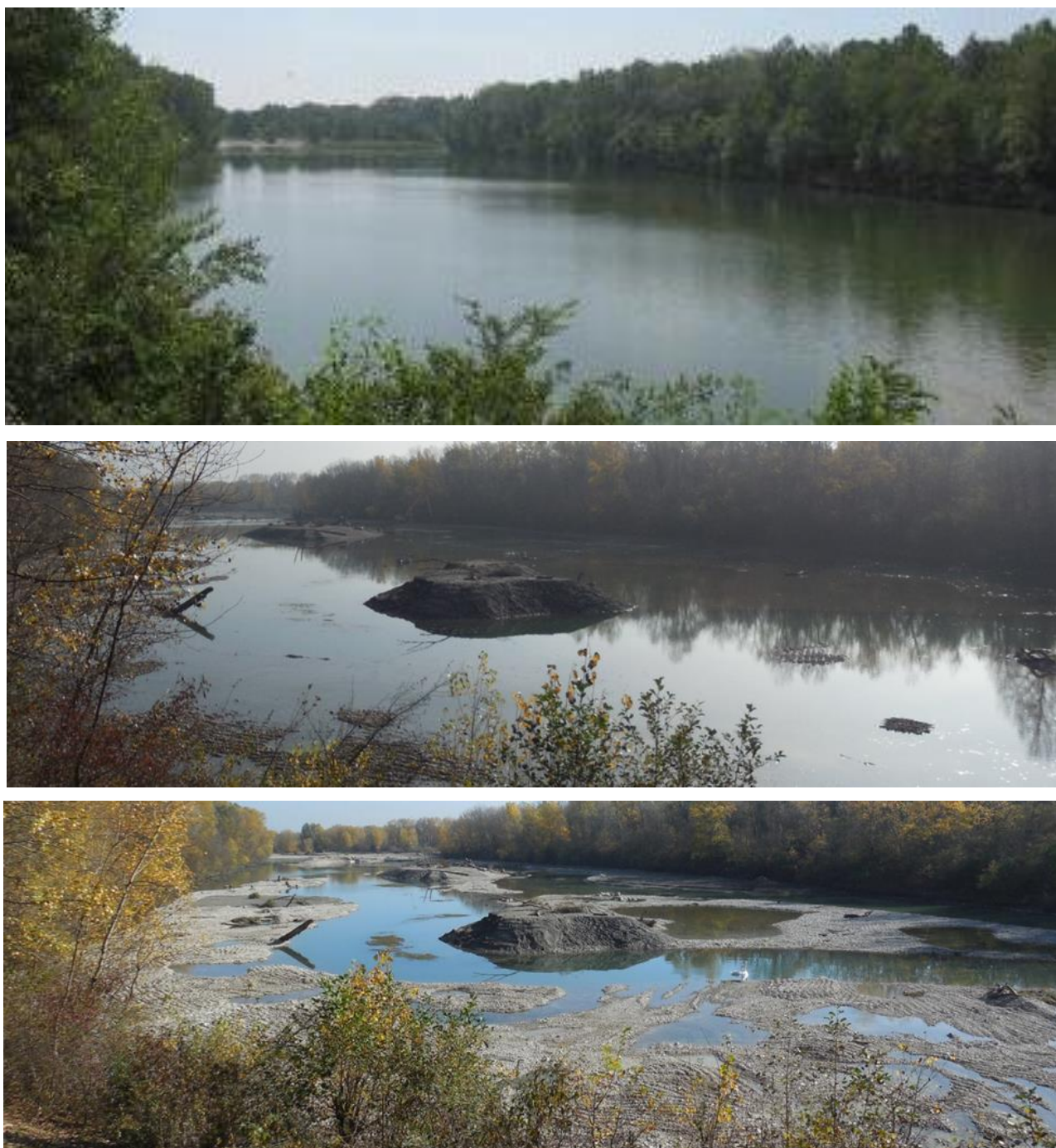
Figure 6: Canal écreteur – en haut : état initial 2013 ; au milieu : état aménagé à débit réservé 60 m 3 /s en novembre 2015 ; en bas : état aménagé à débit réservé 30 m 3 /s en novembre 2016
