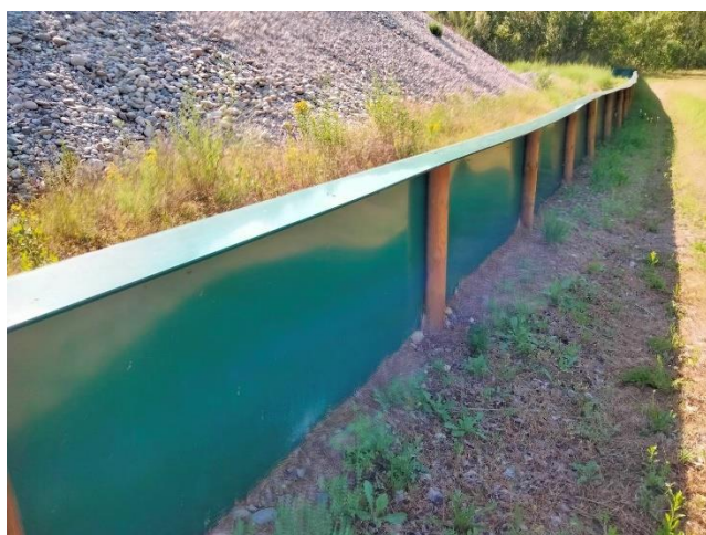
Clôture à amphibiens à remettre en bon état avant la phase travaux, Photo : Ecosphère – Juin 2023
