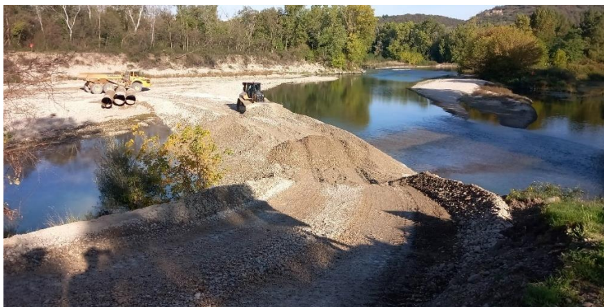
Photographie 12 : Travaux de désengrèvement – octobre 2023
