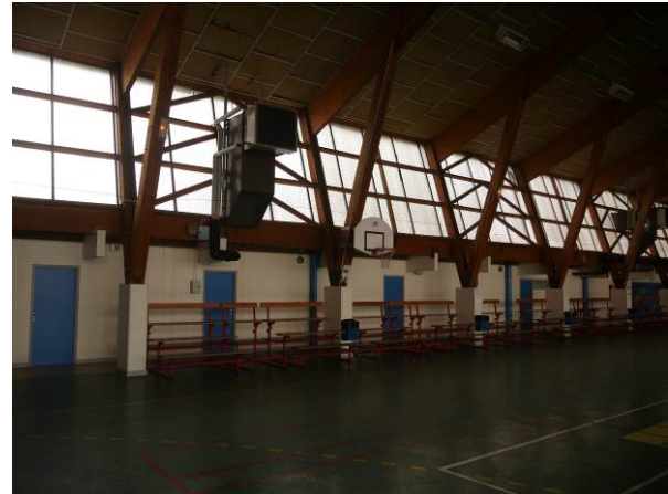
Figure 28 : Vue de la salle multisports et du système de chauffage par aérothermes (prise de vue du 16/10/2023)
