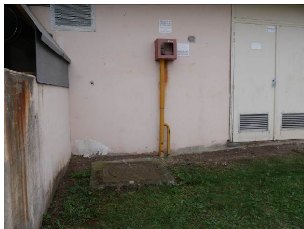
Figure 6 : Vue de la vanne de coupure générale de gaz déconnectée sur la façade Nord du gymnase (prise de vue du 16/10/2023)
