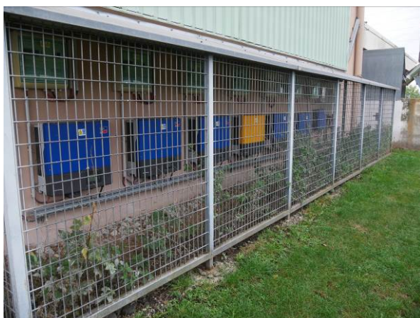
Figure 7 : Vue des onduleurs situés sur la façade Nord du gymnase pour les panneaux solaires de la toiture (prise de vue du 16/10/2023)
