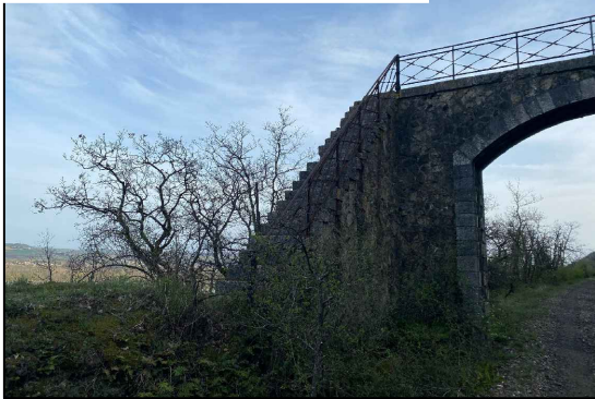
BP2 Pont 9232m sur axe projet sur Champagne Pont à reprendre avec création d'une dalle et garde-corps
