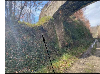
Y Soutènement sous pont 6450m sur axe projet sur Saint Désirat Enlever végétation Maçonnerie à refaire pour pérenniser le pont et le talus sur la voie
