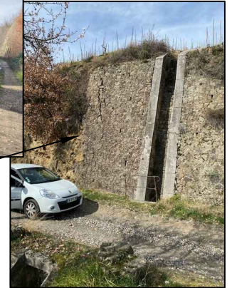
BJ Tranchée couverte de 25ml, 8400m sur axe projet sur Champagne Dévégétalisation, nettoyage, diagnostic et travaux de consolidation si nécessaire
