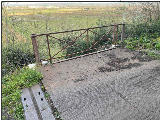
BP2 Pont 9232m sur axe projet sur Champagne Pont à reprendre avec création d'une dalle et garde-corps
