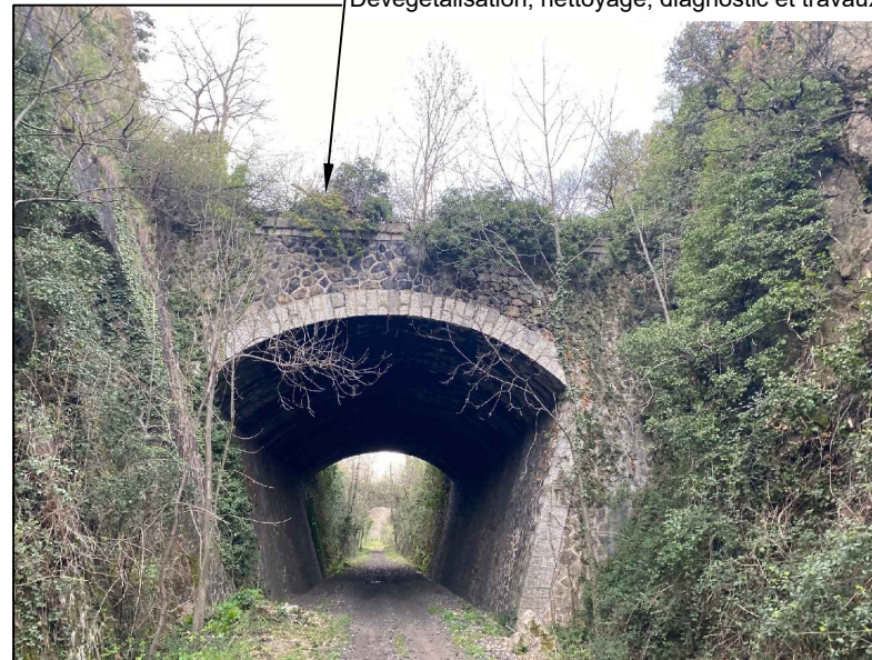
BJ Tranchée couverte de 25ml, 8400m sur axe projet sur Champagne Dévégétalisation, nettoyage, diagnostic et travaux de consolidation si nécessaire
