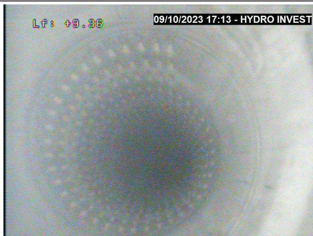
Photo N° 6 – Prof. : 9.3 m/rep – Artésianisme Sommet de la première crépine à nervures repoussées à 9.7 m/rep. La tôle roulée soudée forme une crépine en spirale. Eau toujours légèrement trouble
