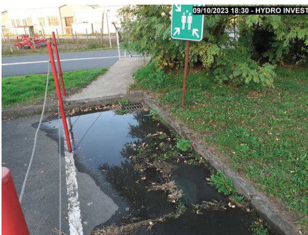
Photo N° 5 Ecoulement de l'eau artésienne sur le parking, en direction du réseau d'eau pluviale
