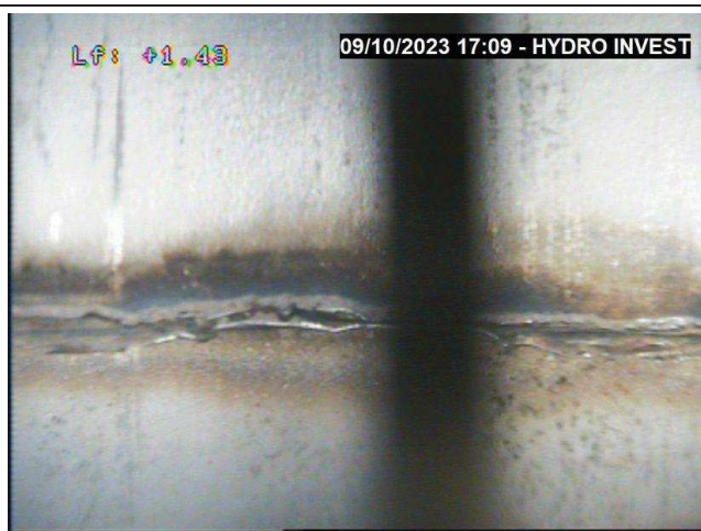
Photo N° 3 – Prof. : 1.4 m/rep – Artésianisme Soudure transversale entre tube (soudure bord à bord) visuellement en bon état. Auréole de chauffe du cordon de soudure bien visible
