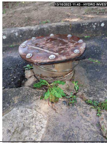
Photo N° 8 Fermeture étanche du forage artésien avant départ du chantier
