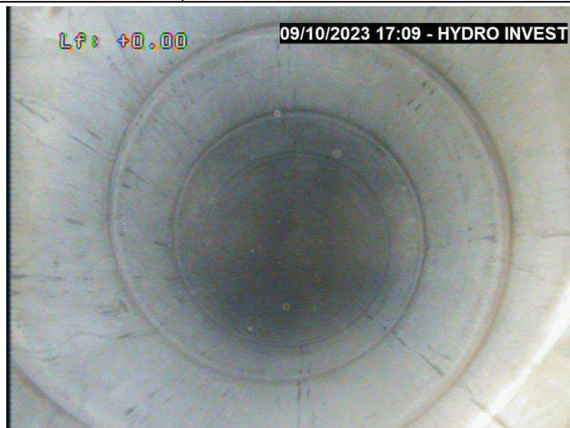
Photo N° 2 – Prof. : 0.0 m/rep – Artésianisme Tube plein en inox Ø 229x242 mm, tôle roulée soudée en parfait état mécanique. Soudure longitudinale en spirale également en bon état
