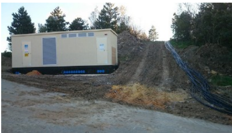
Exemple de poste de livraison d'une centrale solaire
