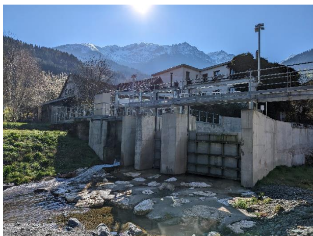
Figure 7: barrage de prise d'eau et passage sous une maison en début de tronçon
