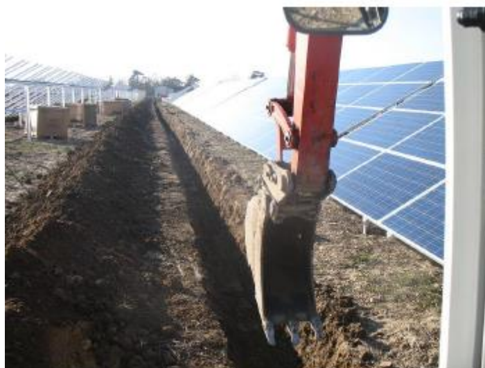
Tranchée pour le passage des câbles
