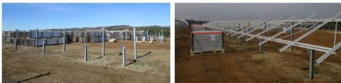
Photographies de la pose des supports
