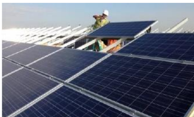
Photographie pose des panneaux sur les supports
