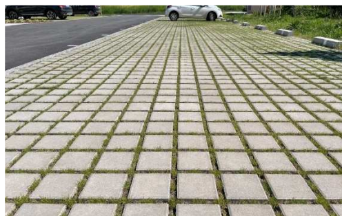
Exemple de pavés drainants en béton avec écarteurs
