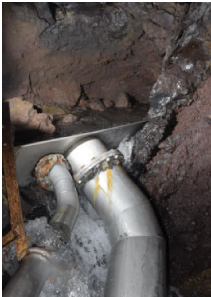
Figure 15. Émergence au griffon (GSA 2019) et dispositif de capture
