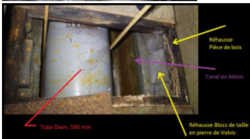
Figure 16. Conduite PVC Ø500mm (GSA 2019) sous le dallage de la galerie, installée dans l'ancien chenal
