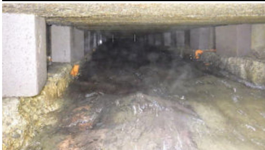
Figure 17. Chenal juste en aval du griffon (GSA 2019). Deux petites canalisations auxiliaires en briques oranges sont visibles
