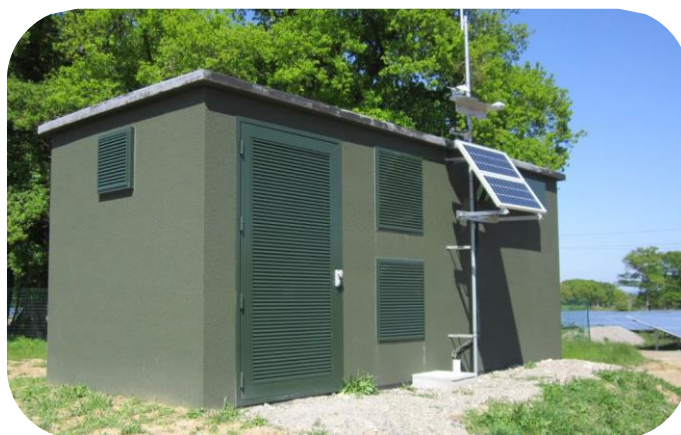
Figure 6 : Exemple de poste de livraison – Source : Melvan
