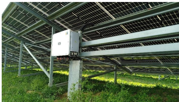
Figure 9 : Exemple d'onduleur accroché derrière les tables de modules
