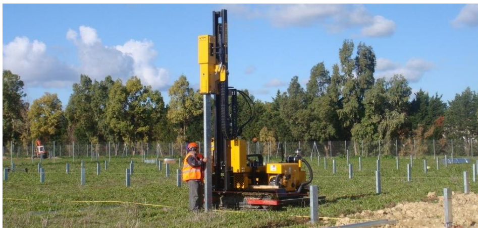
Figure 8 : Sonnette de battage hydraulique
