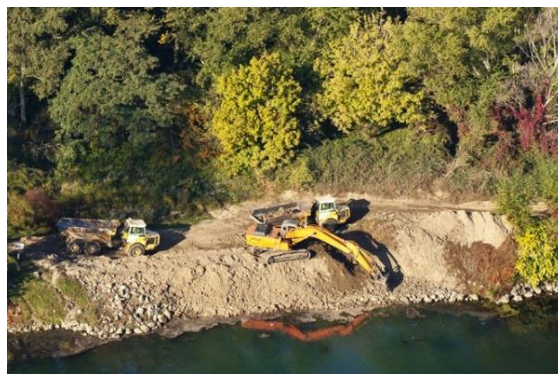
Figure 4 : Degré 2 – Démantèlement partiel ouvrages Girardon – Cornas (VR Bourg les Valence).
