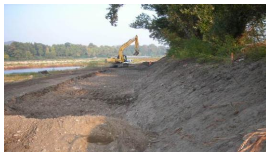
Figure 5 : Degré 3 – Démantèlement total digue longitudinale Girardon – Pont St Esprit (VR Donzère Mondragon).
