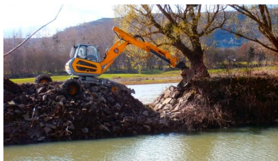
Figure 3 : Degré 1 – Brèche sur l'entonnement de la lône de la Platière (VR de Péage de Roussillon).
