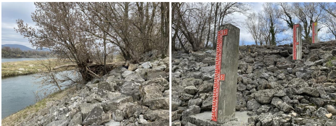
Figure 27 : Présence d'embâcles/laisses de crue à quelque 6 mètres au-dessus du niveau d'étiage à l'aval du barrage (Biotech 8/03/2022)
