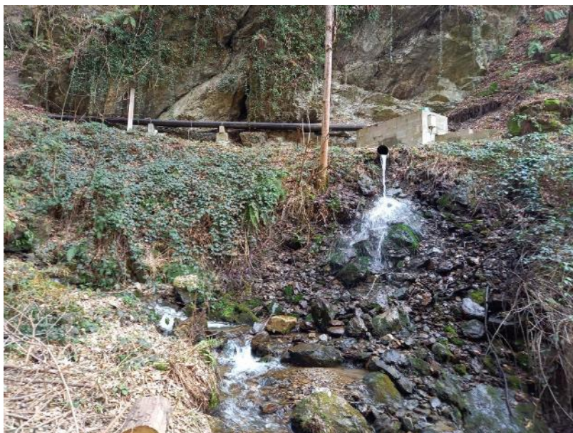
Photographie 78: Captage et surverse en rive gauche du Nant Brun vers l'altitude 425 m.
