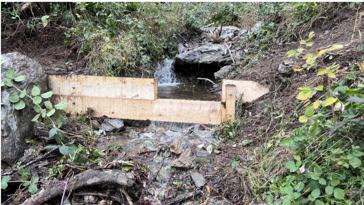
Figure 12 Seuil sur le Nant Brun (centre)
