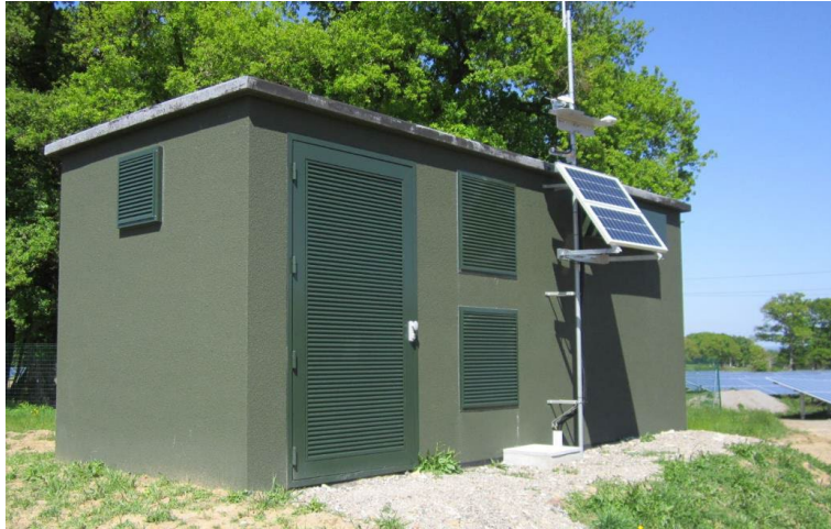
Figure 18 : Exemple de poste de livraison – Source : MELVAN
