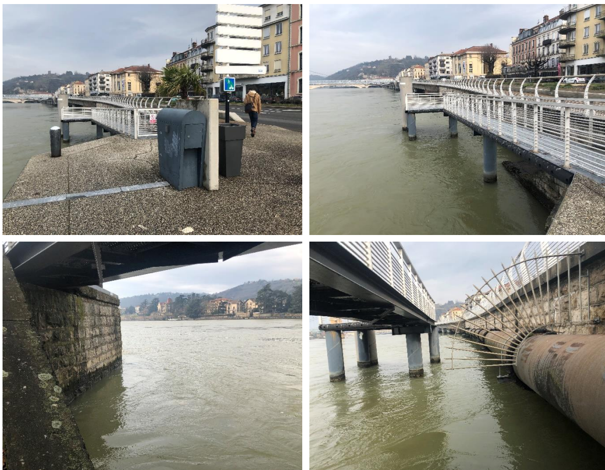
Figure 6 : Photographies de la passerelle de débarquement métallique existante en extension du quai amont en béton (Source : Note de conception WSP, 2023)
