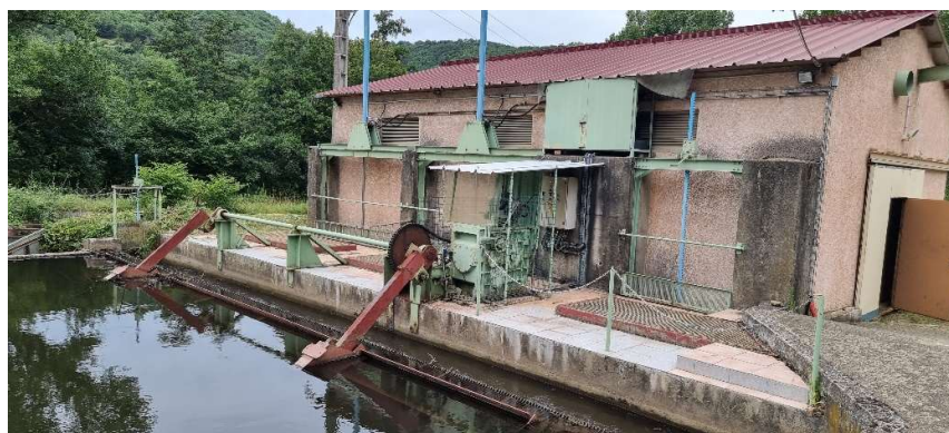
Photographies 5 et 6 – Vannes de tête et canal d'amenée – 21 01 2020
