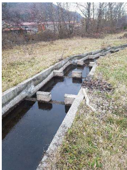
Photographies – Passe à poissons au niveau de l'usine
