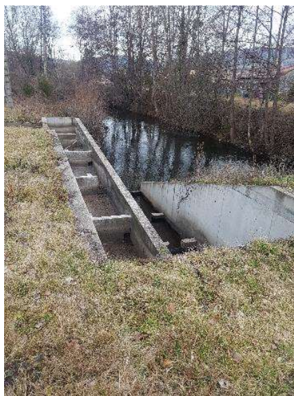
Photographies – Passe à poissons au niveau de l'usine
