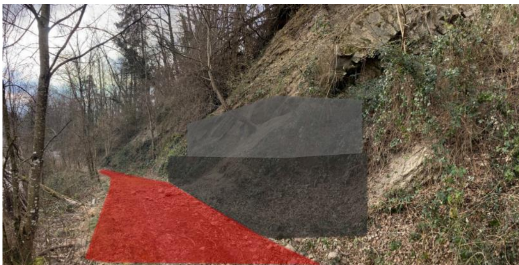
Figure 13 – Protection provisoire à mettre en œuvre au niveau de la falaise sur l'accès rive gauche (voir emplacement sur la Figure 11)
