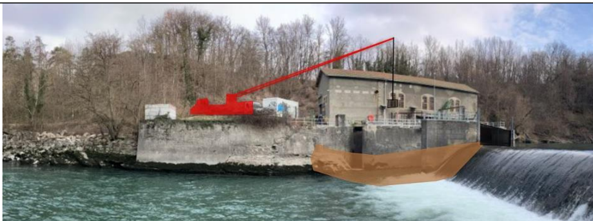
Figure 17 – Projection de l'emprise du batardeau en rive droite au niveau de l'usine
