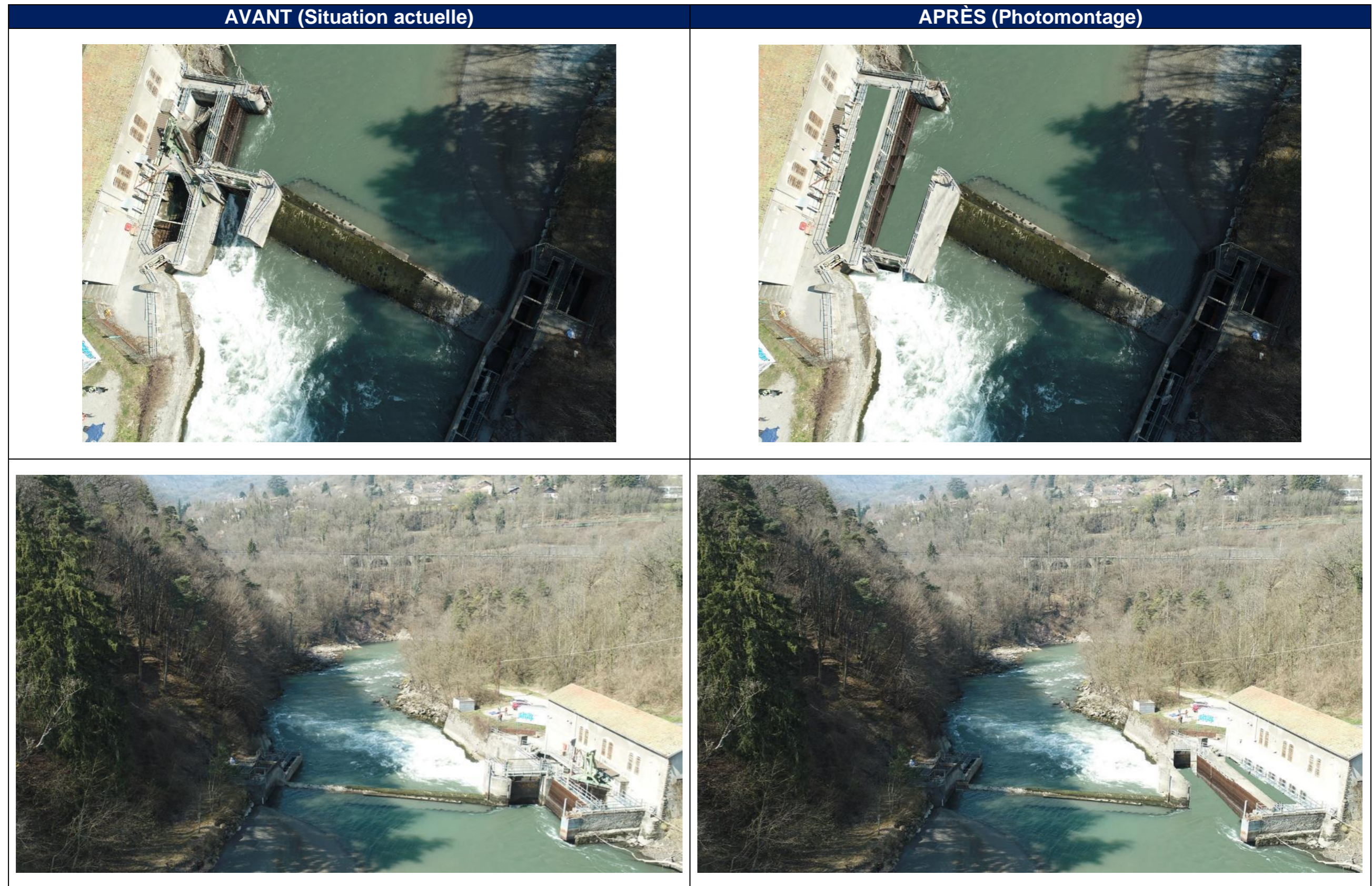
Figure 4 – Vues « avant/après » de la nouvelle prise d'eau
