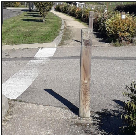
Potelets rond en bois traité autoclave anti stationnement diam. 12cm env. /ht 0.80m
