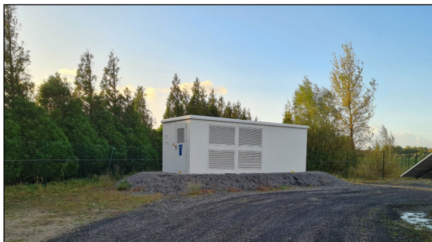
Figure 14. Exemple de poste de transformation
