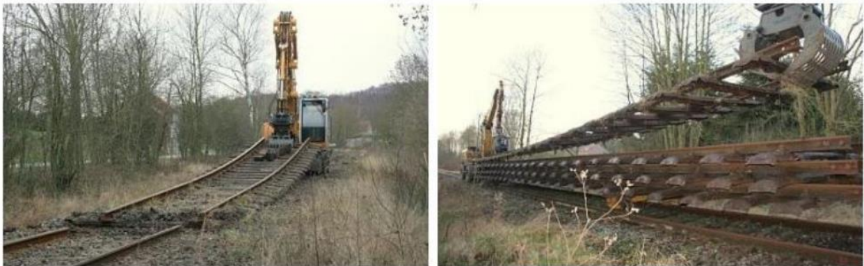
Figure 2 Exemple d'opération de déferrage en vue de la création d'une voie verte. Source : étude de faisabilité 2012
