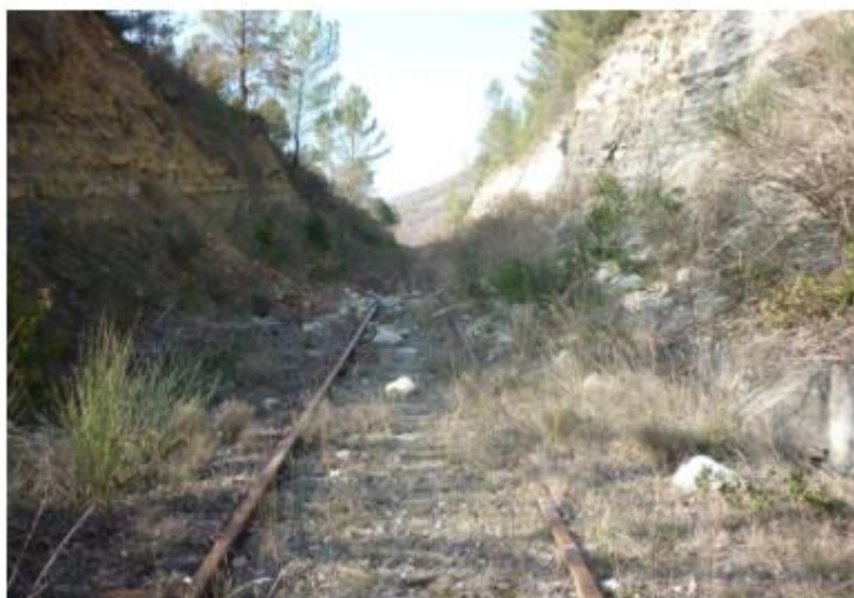
Photo 1 : Tranchée rocheuse nécessitant la purge des parois et le surcreusement des pistes pour former des pièges à cailloux
