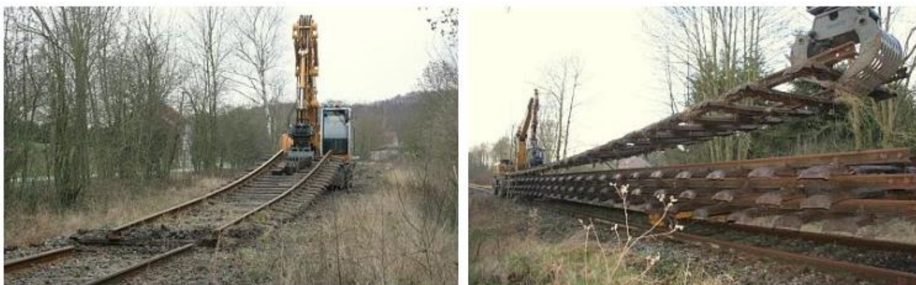
Photo 2 et Photo 3 : Exemples d'opérations de déferage en vue de création d'une voie verte Source : Étude de faisabilité 2012
