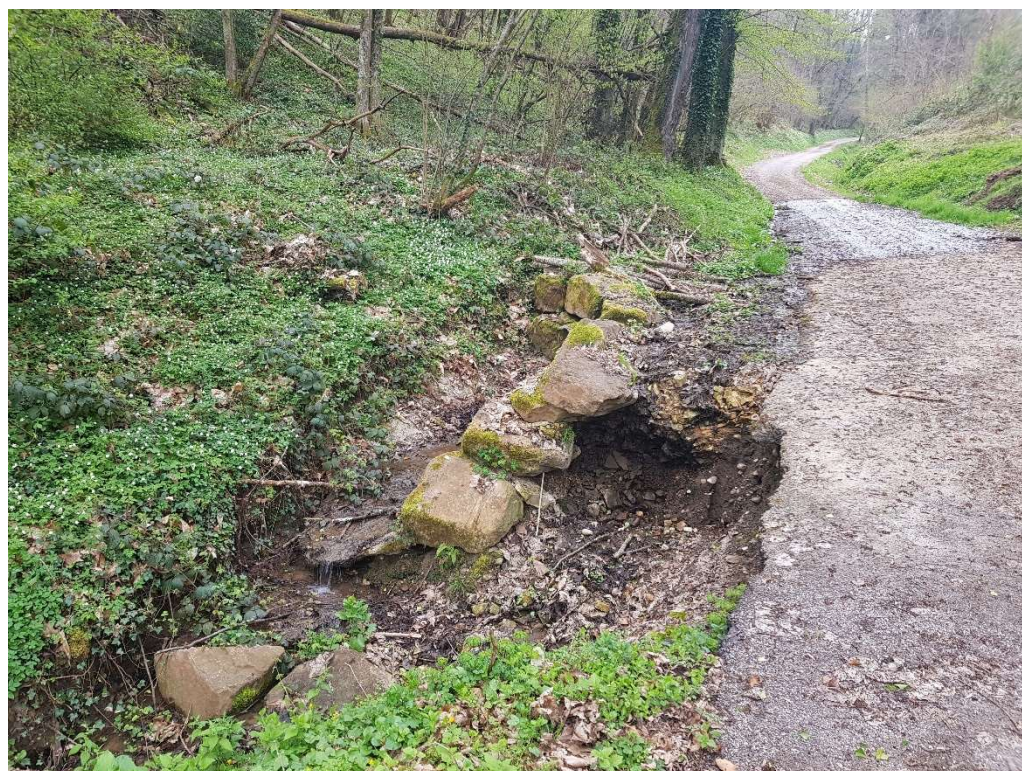
Figure 2-9 (droite) : très forte érosion du talus en aval du busage
