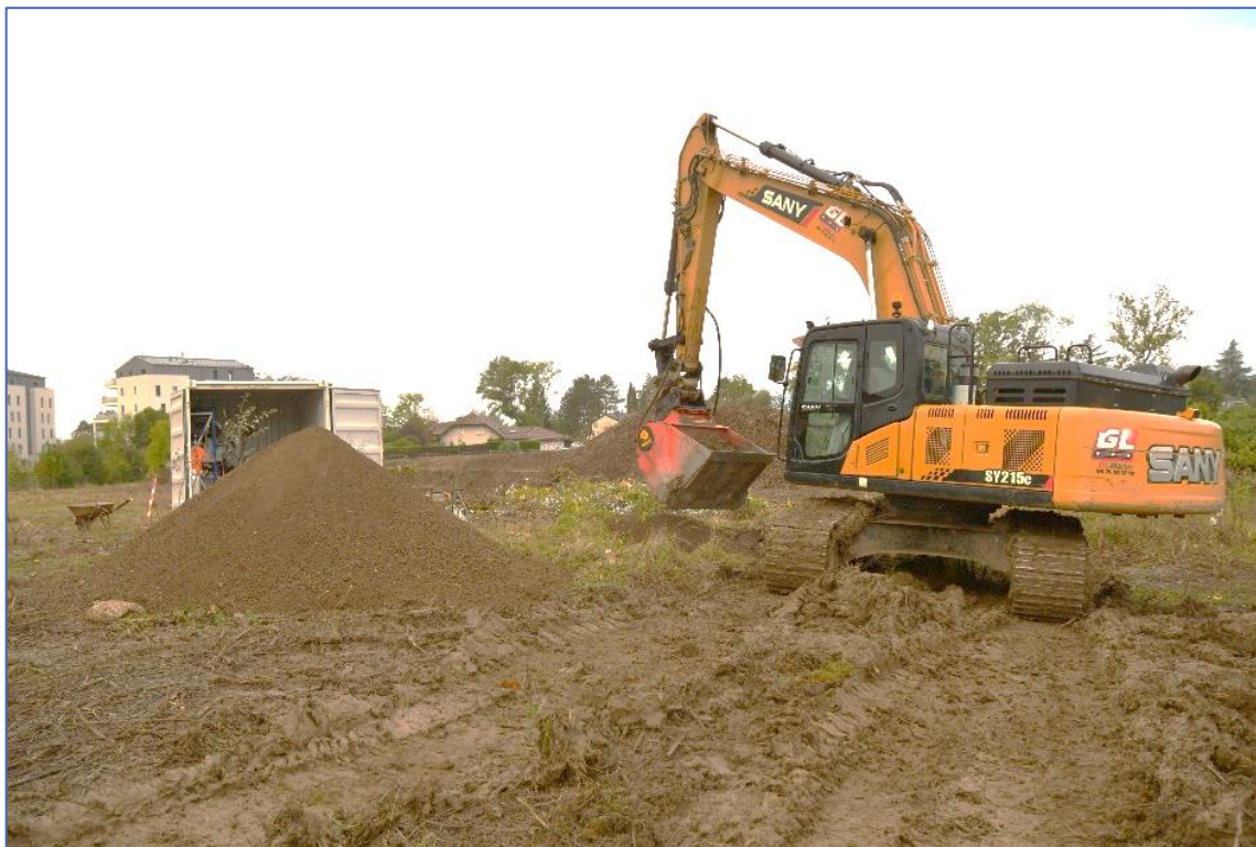
PHOTO 3 PELLE MECANIQUE DE 20T AVEC UN GODET CONCASSEUR PASSER AU CRIBLE
