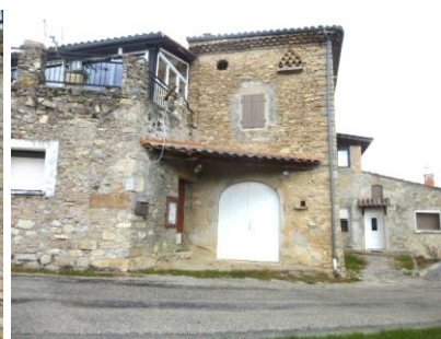
2- Hameau de Lallet , parcelle 225 située à l'éperon sud du hameau : Utilisation de menuiseries en PVC blanc dans un bâtiment ancien, création d'ouvertures sans encadrement d'ouverture, utilisation de plaques fibro-ciment non recouvertes de tuiles
