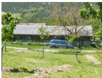
1- Hameau de Saint Etienne , parcelle 48: Bâtiment agricole ne figurant pas au cadastre, agglos non enduits, toiture fibrociment non recouvert
