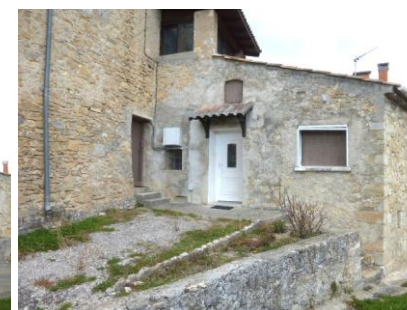
2- Hameau de Lallet , parcelle 225 située à l'éperon sud du hameau : Utilisation de menuiseries en PVC blanc dans un bâtiment ancien, création d'ouvertures sans encadrement d'ouverture, utilisation de plaques fibro-ciment non recouvertes de tuiles
