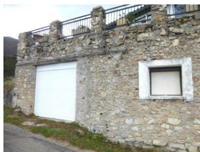
2- Hameau de Lallet , parcelle 225 située à l'éperon sud du hameau : Utilisation de menuiseries en PVC blanc dans un bâtiment ancien, création d'ouvertures sans encadrement d'ouverture, utilisation de plaques fibro-ciment non recouvertes de tuiles
