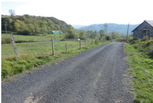
Exemple de voie forestière en granulat basaltique (piste existante près du hameau de Bournac)
