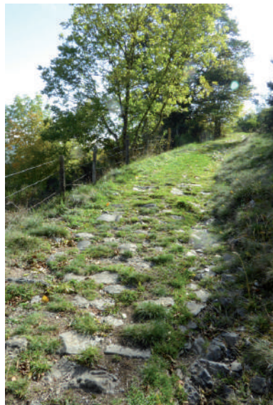
Certains chemins pentus présentent un empierrement grossier qui prend l'allure de calade et permet de limiter l'érosion. Ce type de revêtement peut aussi servir d'inspiration pour le traitement de sols des futures voies forestières.
