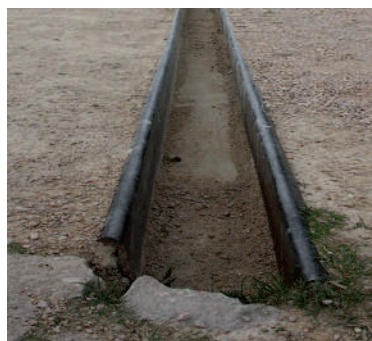
Exemple de rigole ici métallique pour évacuer l'eau de ruissellement des pistes forestières et ainsi limiter l'érosion.
