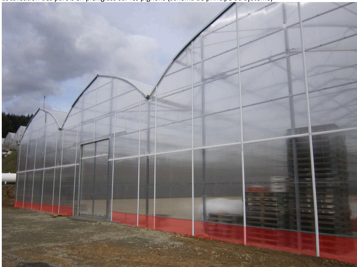
Localisation des parois en plexiglass sur les pignons (schéma de principe du système)
