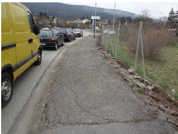
Trottoir en rive de la route BRILLAT SAVARIN (revêtements dégradés / soutènement en cours d'effondrement)
