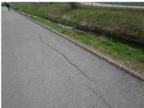
Revêtement – affaissement en cours sur 20m
