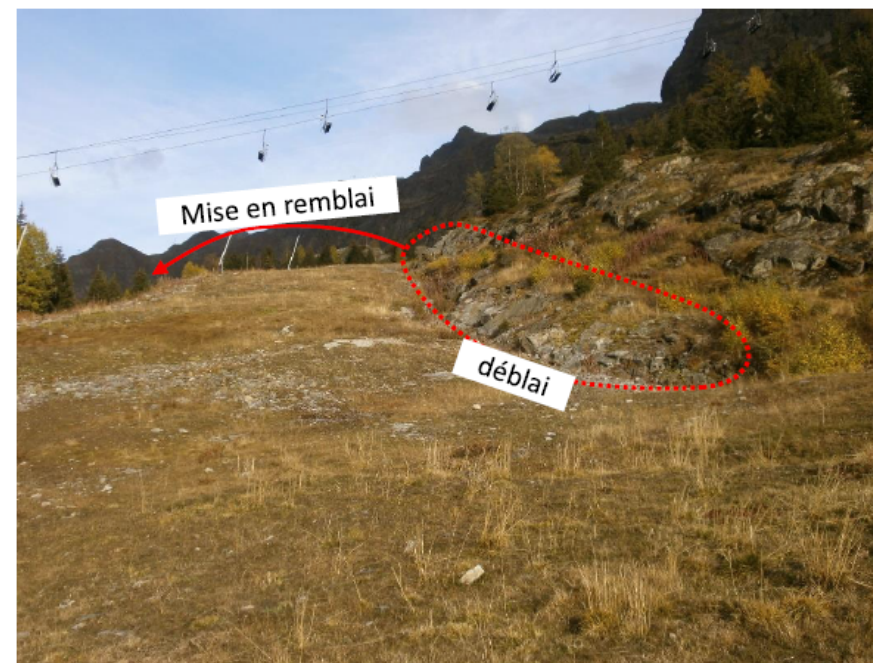
Zone intermédiaire : élargissement en déblai/remblai
