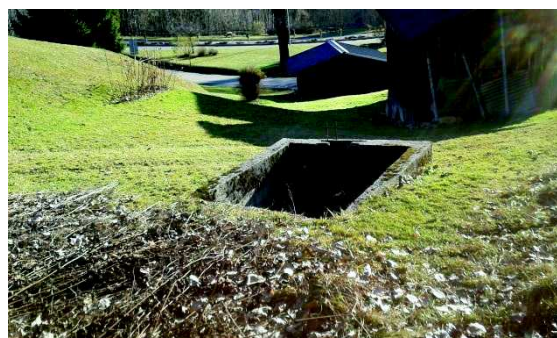
Vue 6 : Ouvrage en béton qui collecte les eaux du ruisseau qui s'écoule en limite du projet.
