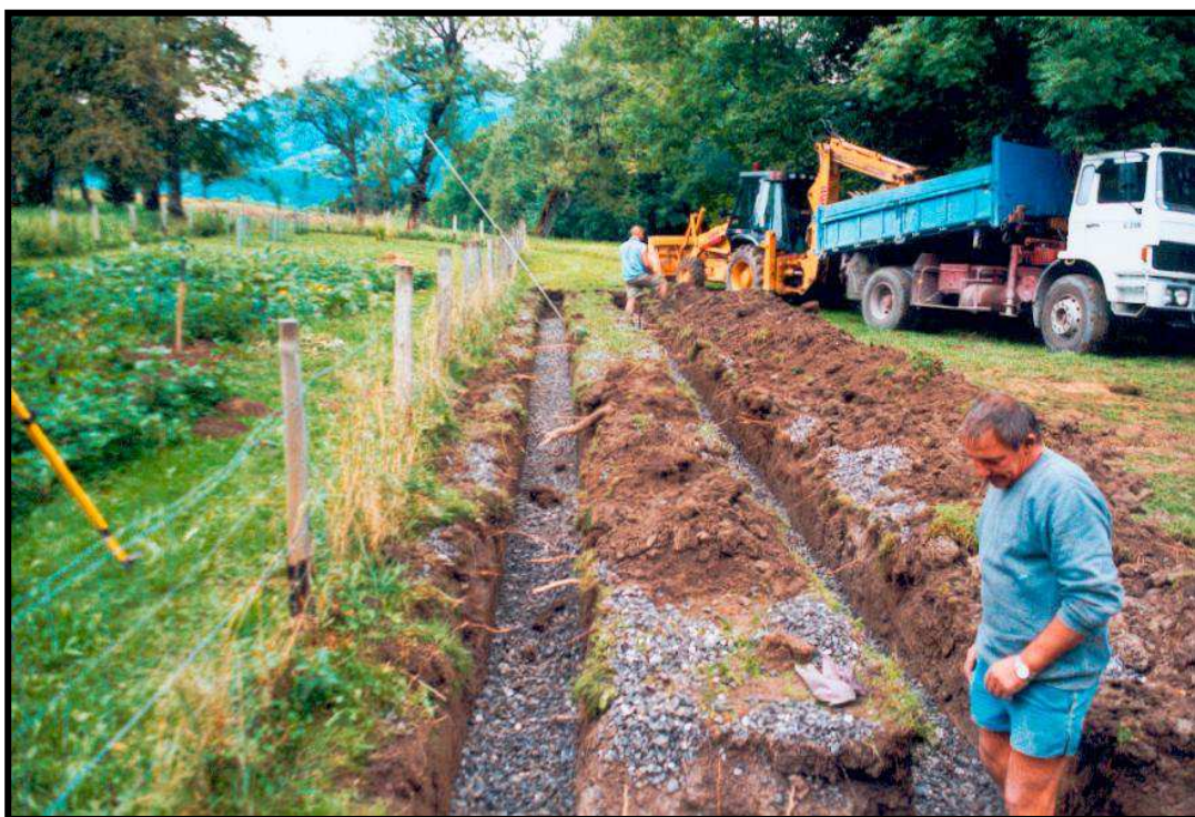
Tranchées d'épandage en cours de réalisation
